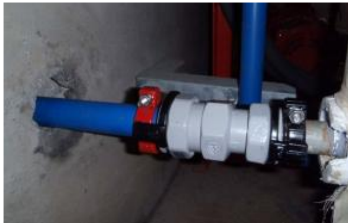
【パイプシャフト内 既設鋼管との一次接続】
