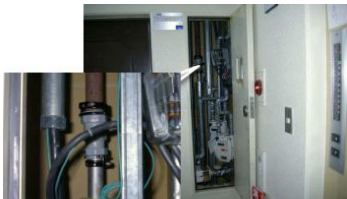
【パイプシャフト内 既設鋼管との一次接続】
